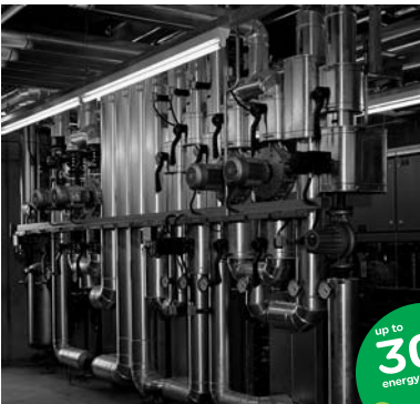
Управление насосной станцией
