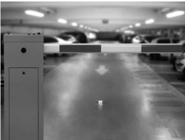
Шлагбаум, управляемый ПЧ ATV 12
